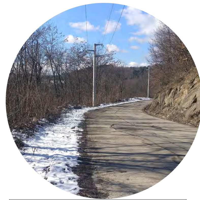
Schimbarea bruscă a cotei de nivel crează diferite probleme precum risc la inundații, cadere de pietre, lemn, etc
